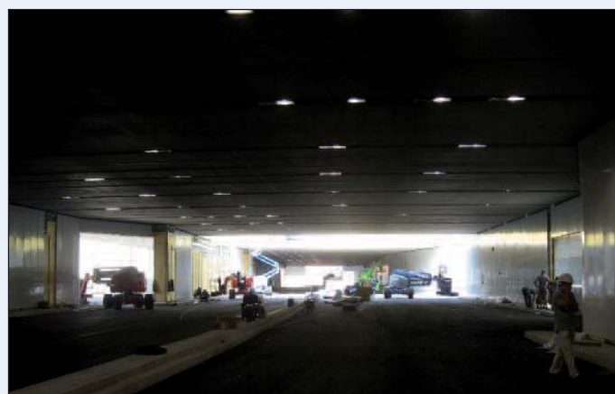
Figura 21 - Lavori di rivestimento con pannelli fonoassorbenti
