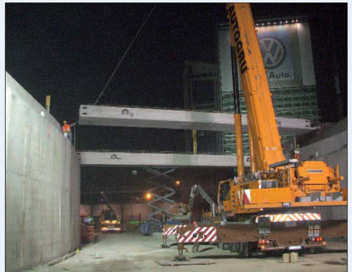
Figura 17 - La posa delle travi in notturna
