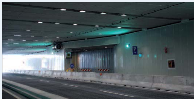
Figura 31 - Una vista dell'interno del tunnel finito
