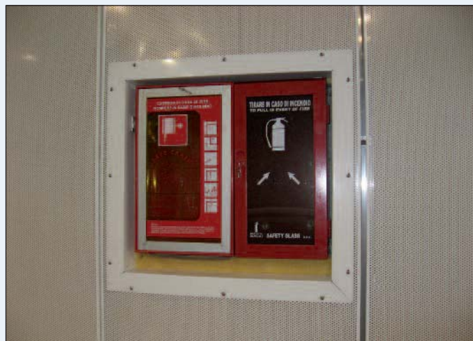
Figura 28 - Gli idranti e le cassette di estintori per antincendio
