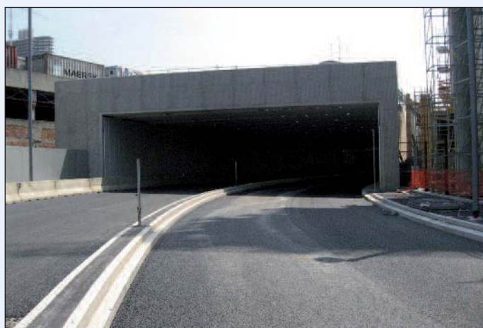
Figura 5 - L'imbocco lato stazione di Porta Garibaldi
