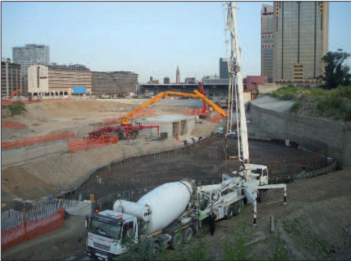
Figura 15 - Il getto del calcestruzzo per la realizzazione delle fondazioni del ricciolo
