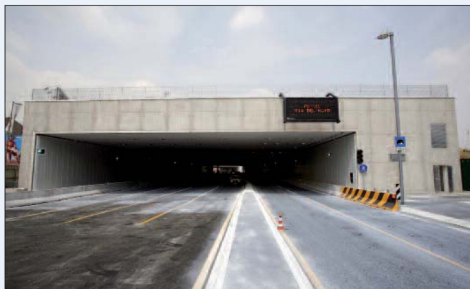
Figura 4 - L'imbocco del tunnel da Via Melchiorre Gioia
