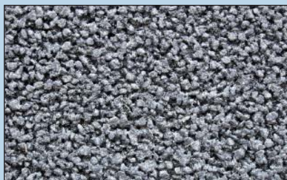
Figura 25 - Il conglomerato drenante trattato con Coverlite®
