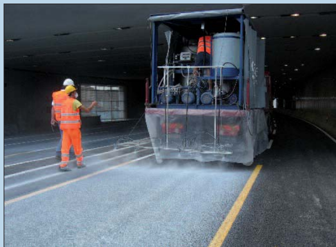
Figura 24 - La posa in opera con applicazione a freddo sulle corsie
