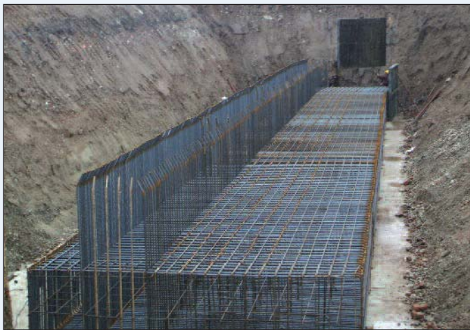
Figura 13 - Grandi quantità di ferro per l'armatura dei gabbioni di fondazione
