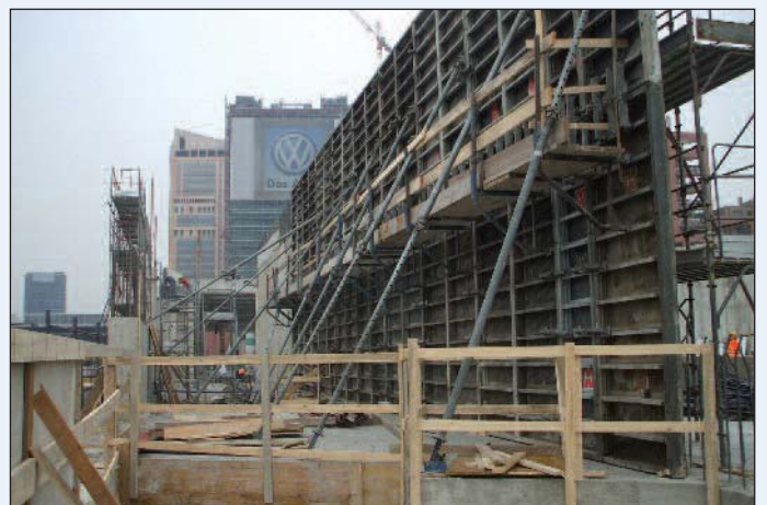
Figura 14 - Le casseforme per il getto in opera delle spalle di appoggio delle coperture
