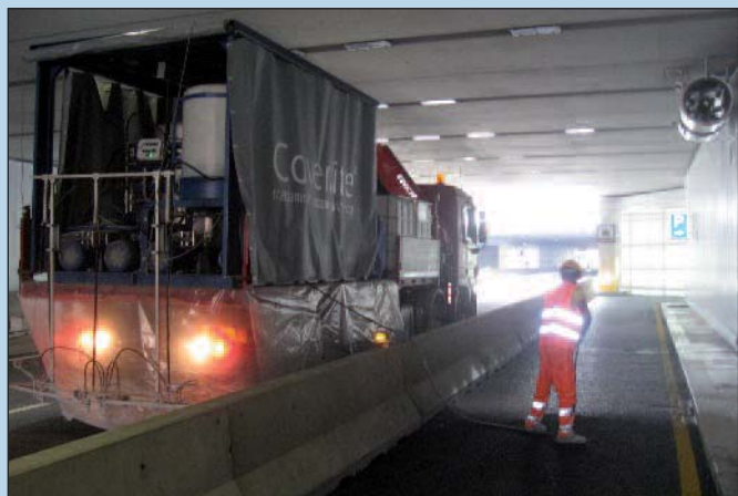
Figura 23 - La spruzzatura a mano del biossido di titanio sul tratto pedonale
