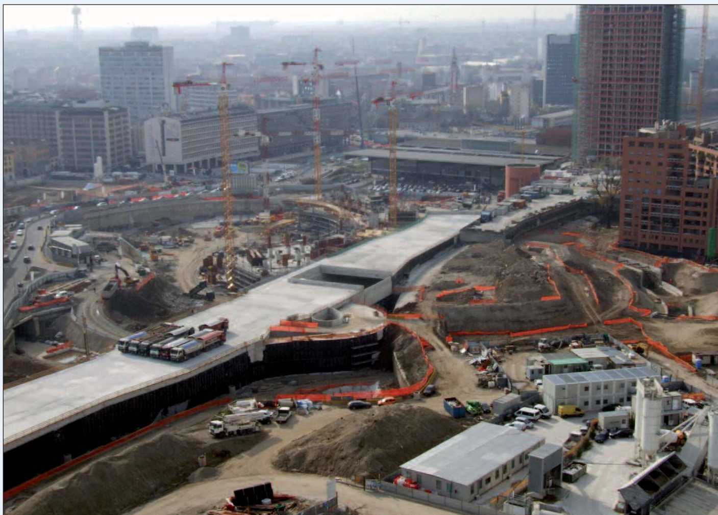
Figura 32 - Una panoramica del tunnel ultimato
