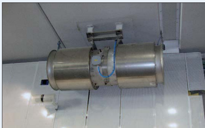
Figura 26 - Uno degli otto ventilatori per l'evacuazione dell'aria
