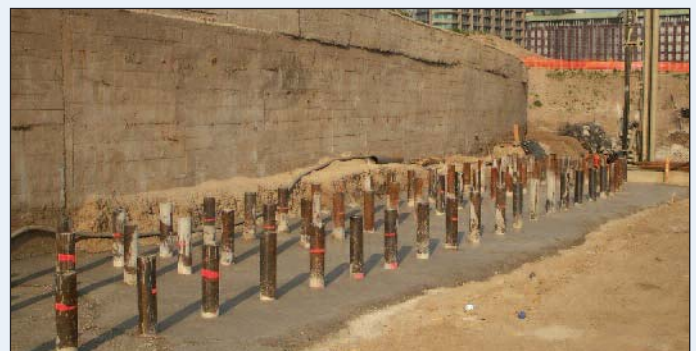
Figura 12 - Il consolidamento della fondazione con l'infissione di 235 micropali
